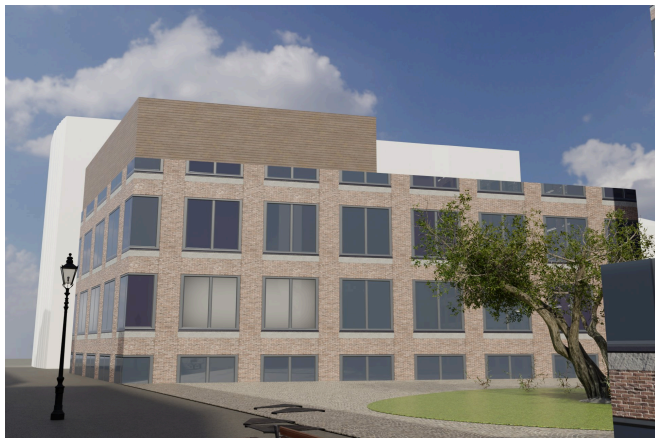
Depuis la rue des Rancy, à hauteur d'œil : l'attique en retrait reste discret depuis l'espace public.
