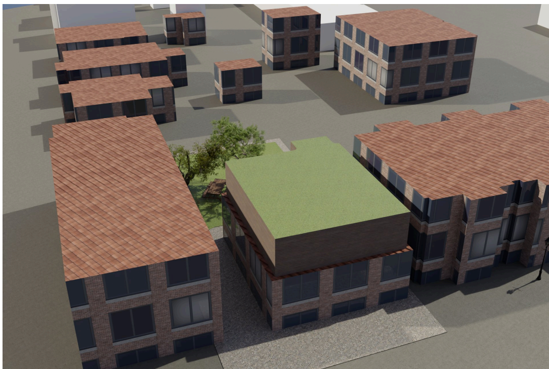
Vue d'ensemble : le deuxième étage en bois clair à toiture végétalisée sur le bungalow de 1957, le jardin conservé à l'ouest. Volumes reconstruits depuis les emprises de toits 2016 et les étages du rôle foncier.
